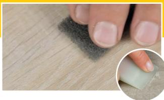
**Plan abtragen und entfetten:** Mit der Kante des Füllstoff-Hobels in kreisenden Bewegungen das Wachs verreiben und plan arbeiten. Anschließend mit dem grauen Vlies aus dem Füllstoff-Hobel die instandgesetzte Stelle und das Umfeld entfetten.
