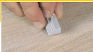
**Angleichen: Struktur:** Porenbild bzw. Struktur der Oberfläche durch leichtes Einritzen mit der Kantenspitze des Füllstoff-Hobels herstellen. **Farbe:** Schadstelle mit dem nächst dunkleren Weichwachs nacharbeiten.
